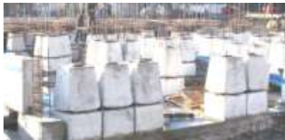
Рис.10 Фотография кинематических опор в проектное положение без устройства монолитного верхнего ростверка.
